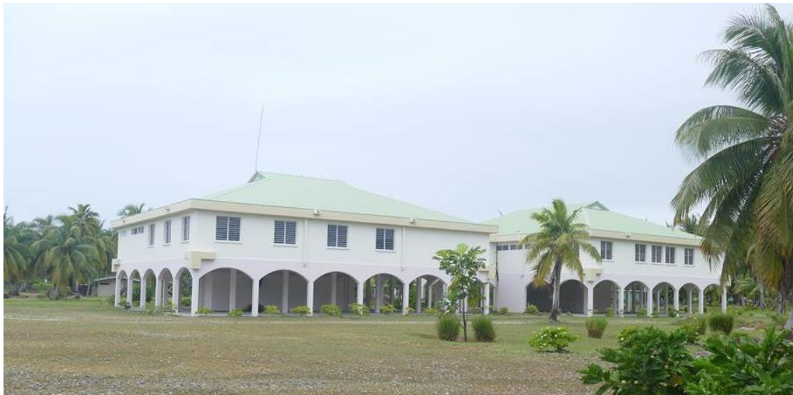
Abri paracyclonique sur l’atoll de Tikehau (Polynésie française) – prévu pour accueillir 700 personnes pendant 72 heures
